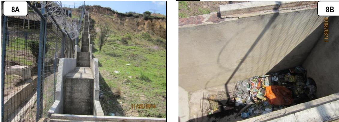
**Fotografías Nos. 8A y 8B. Antiguo Chircal María de Munevar.** Se aprecia la obra construida para la captación y conducción de las aguas de escorrentías y la falta de mantenimiento.
