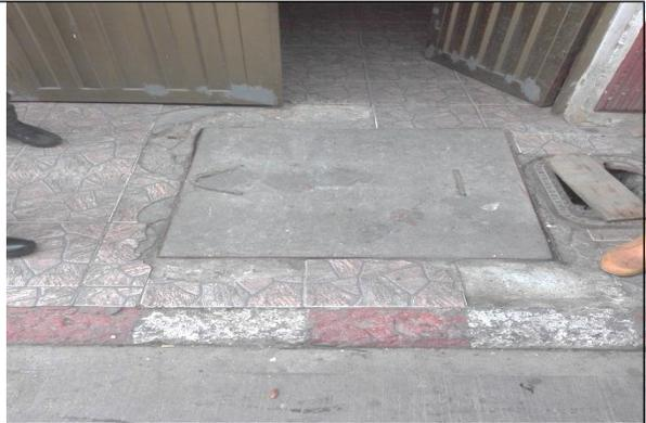
**Fotografía No. 6** Caja de inspección externa
