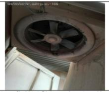
Fotografía No.4 Sistema de extracción del área de pintura.
