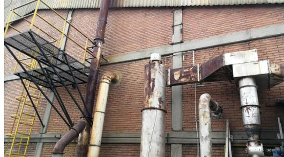
FOTOGRAFIA 6. CICLONES, PRECIPITADOR ELECTROSTÁTICO Y DUCTO DE DESCARGA CON PLATAFORMA DEL PROCESO DE TOSTIÓN.
