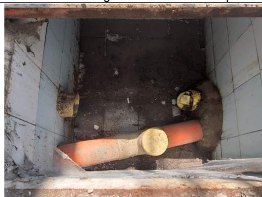
**Foto No. 4.** Caja de inspección externa.
