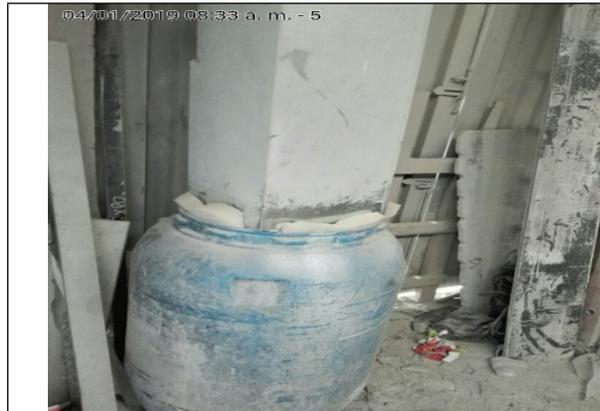
FOTOGRAFÍA N°. 5 TANQUE CON AGUA PARA EL MANEJO DE MATERIAL PARTICULADO DEL CORTE Y PULIDO DE MÁRMOL
