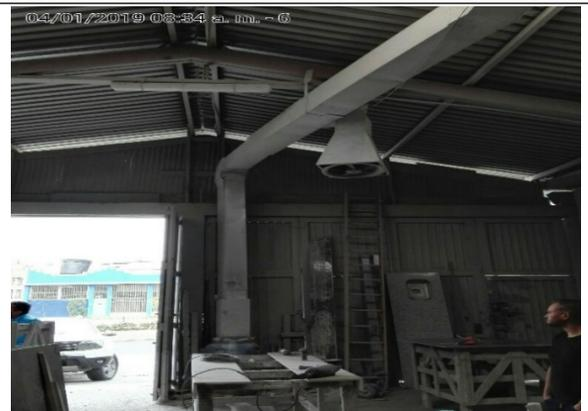
FOTOGRAFÍA N°. 6 SISTEMA DE EXTRACCIÓN Y DUCTO DEL AREA DE PULIDO
