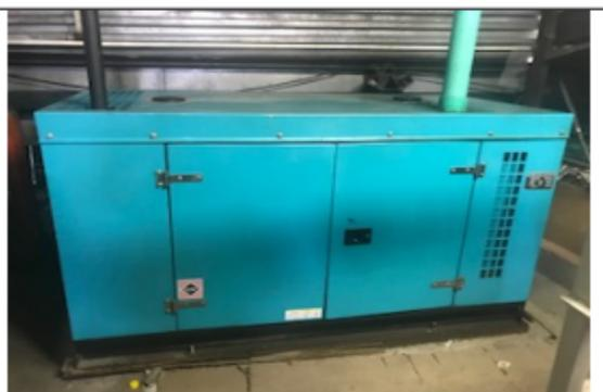
**Fotografía 2.** Planta eléctrica 150 kW
