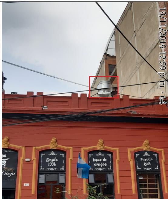
**Fotografía 8.** Punto de descarga del ducto para la parrilla.
