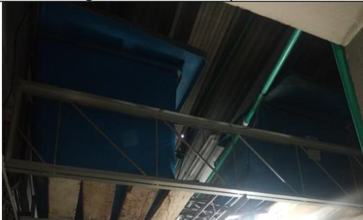
**Foto No. 5.** Tanques aéreos de almacenamiento de agua lluvia
