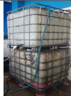
**Foto No. 4.** Tanques de reserva de 1000 lts, ubicados en área de lavado
