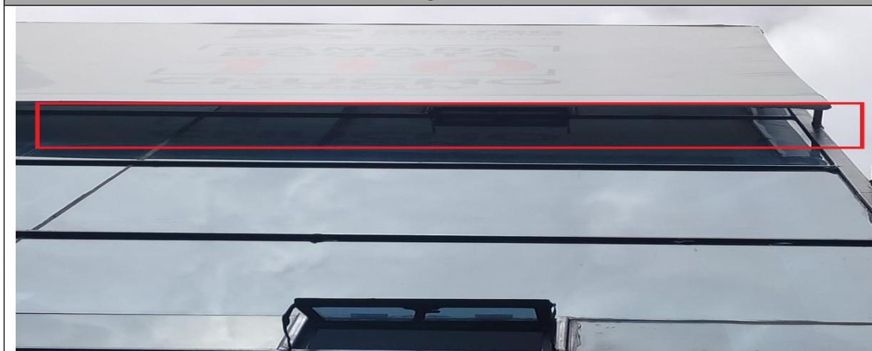
Foto 5 En la cual se evidencia que el aviso ubicado en la parte superior de la fachada sobre la avenida carrera 19, se encuentra volado de la fachada
