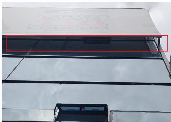
Foto 5 En la cual se evidencia que el aviso ubicado en la parte superior de la fachada sobre la avenida carrera 19, se encuentra volado de la fachada
