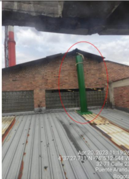
**Fotografía No. 7.** Ducto de los procesos de aplicación de resina, corte y pulido.
