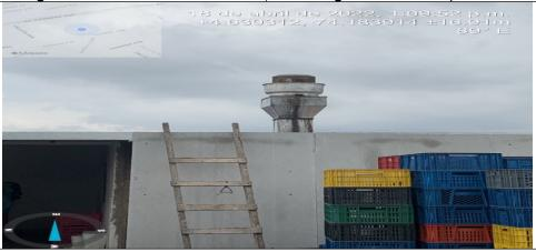
Fotografía No 5. Ducto de descarga de la freidora.
