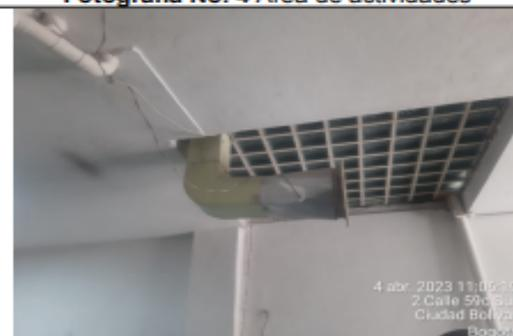
**Fotografía No. 6** Extractor instalado en el proceso de aplicación de pintura
