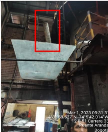
**Fotografía 7.** Ducto caldera de 20 BHP que opera con Diesel
