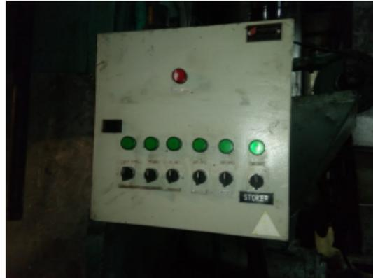
**Fotografía 2:** Levantamiento de sellos en el tablero de control de la Caldera Economic de 80 BHP que opera con carbón mineral
