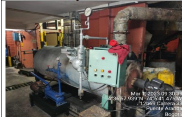
**Fotografía 5.** Caldera de 20 BHP que opera con Diesel
