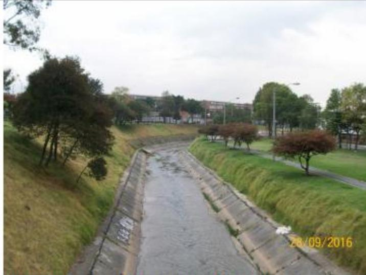
Foto 4. Rehabilitar y re naturalizar las losas existentes en el Canal Fucha, sector Cra 11. Fuente: SDA - SCASP, 2016.
