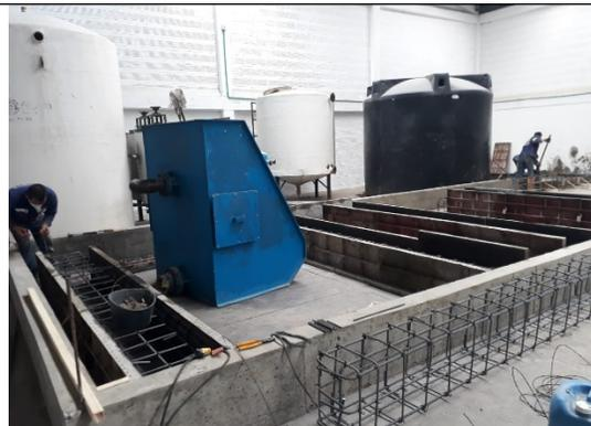
**Foto 4.** Construcción de la Planta de Tratamiento de Aguas Residuales (PTAR), donde se encontrarán: el sistema de tratamiento del agua de proceso, puntos de inspección y aforo.
