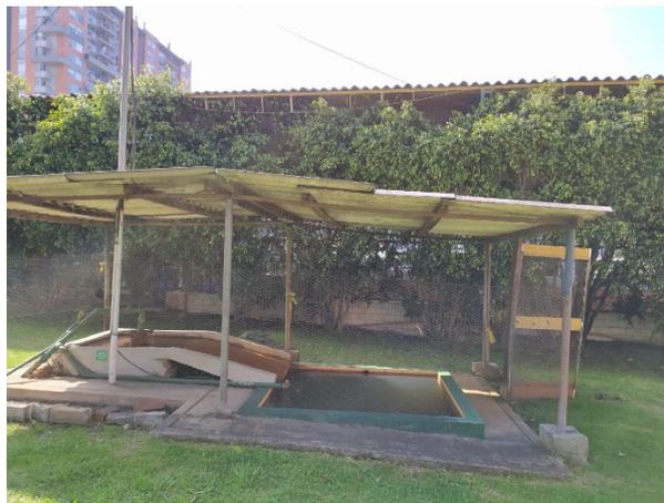
**Fotografía 6.** Perímetro de protección alrededor del pozo constituido por caseta en malla
