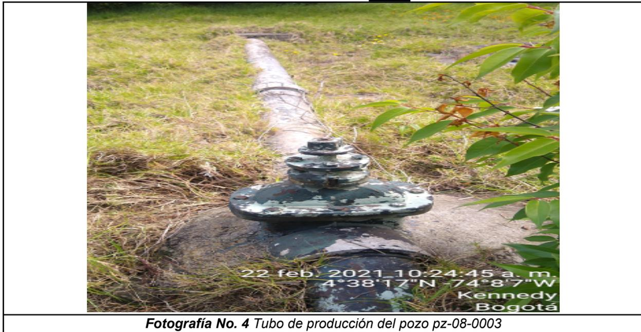
**Fotografía No. 4** Tubo de producción del pozo pz-08-0003
