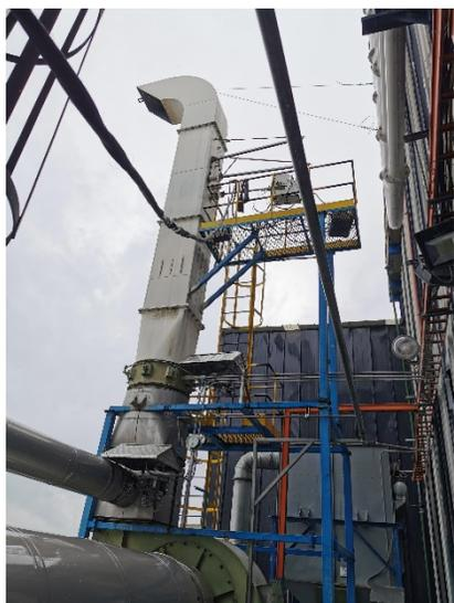
FOTOGRAFIA 11. DUCTO TORRE DE SECADO
