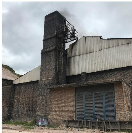
**Fotografía 8.** Chimenea, plataforma y puertos de muestreo
