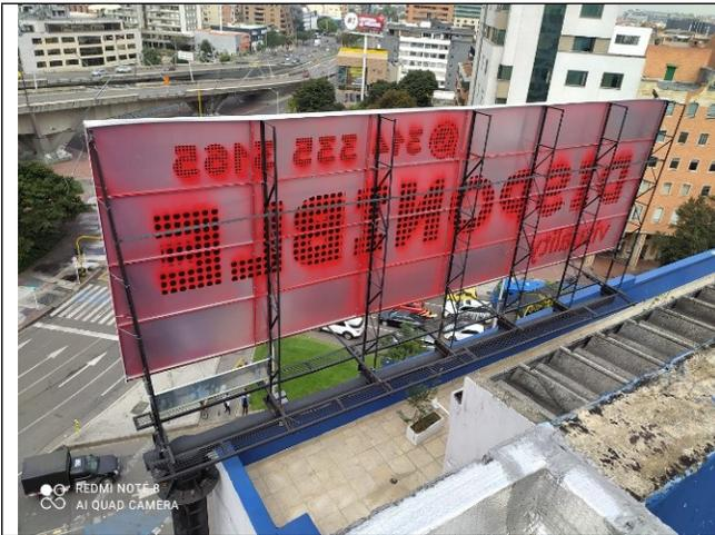
**Foto 1.** Vista de la cubierta y cara posterior del panel y de la estructura de la valla (cerchas)
