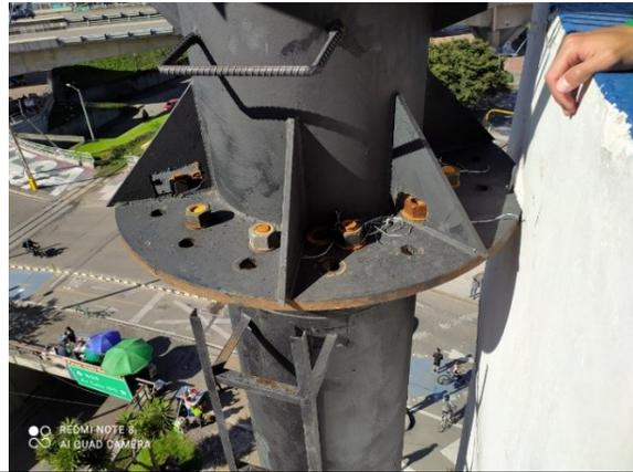
**Foto 4.** Detalle de brida de acople superior.
