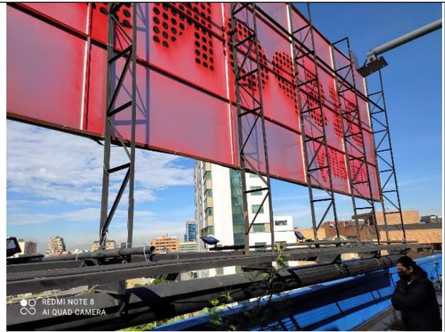
**Foto 2.** Detalle del soporte tubular horizontal y cerchas metálicas
