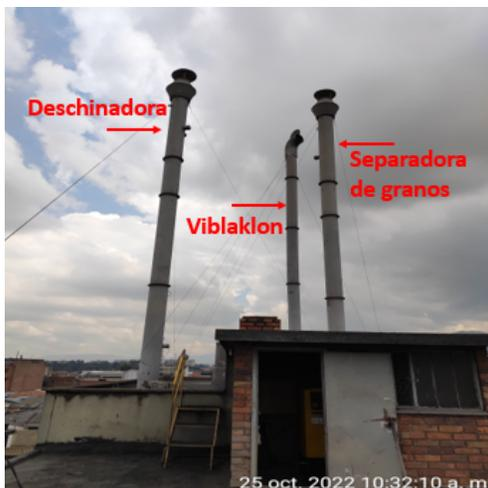
Fotografía 11. Ductos proceso de limpieza
