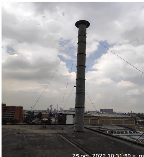
**Fotografía 15. Ducto proceso de molienda (Turbina neumática)**
