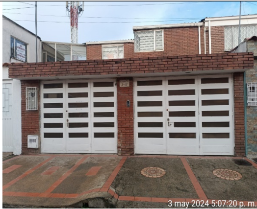
Fotografía No. 1: Fachada externa del predio con nomenclatura urbana KR 73 B # 3 - 68
