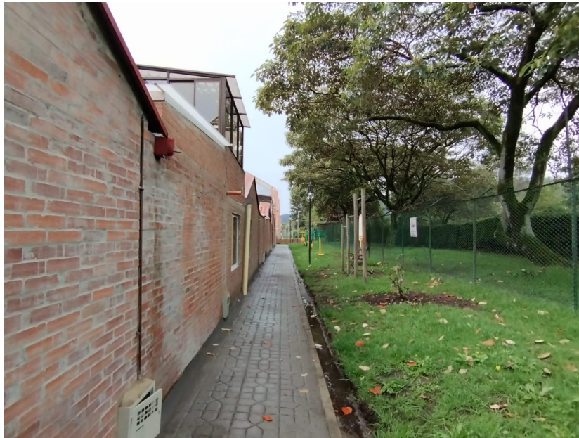
Panorámica de la situación encontrada
