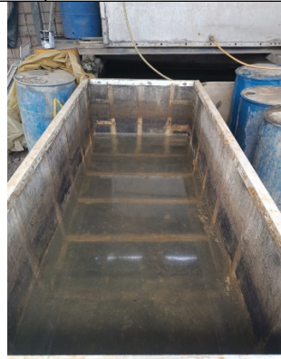
Fotografía No. 7: Contenedor metálico de agua lluvia para limpieza de formaletas
