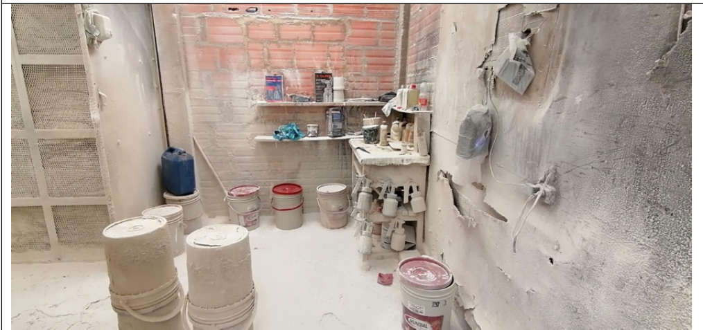
Foto 4. Zona de trabajo ubicado en la tercera planta
