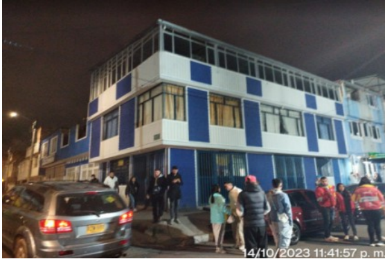
Fotografía No. 3. Fachada del predio objeto de estudio
