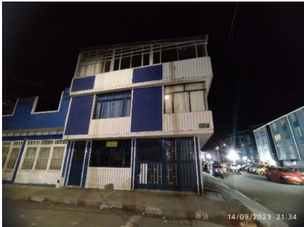
Fotografía No. 1. Fachada del predio objeto de estudio.
