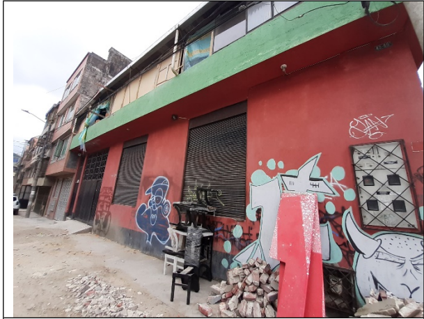
Foto N°. 3 – Fachada del establecimiento
