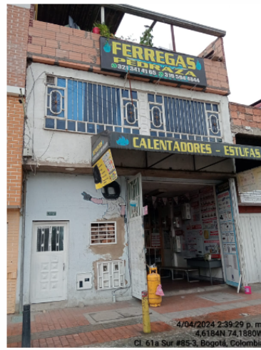
Fotografía No. 2. Fachada de la vista panorámica del predio objeto de interés
