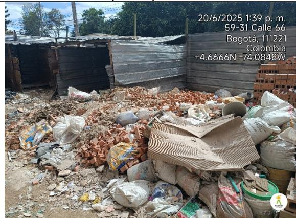
**Imagen 5.** Presencia de acopio de RCD mezclados.
