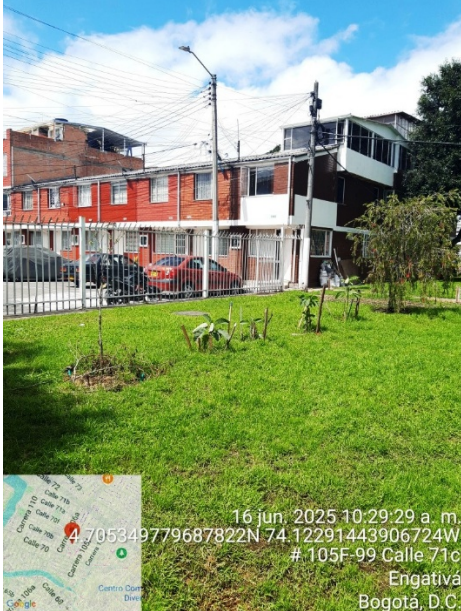
Fotografía 3. Vista general de la zona (objeto de la petición)
