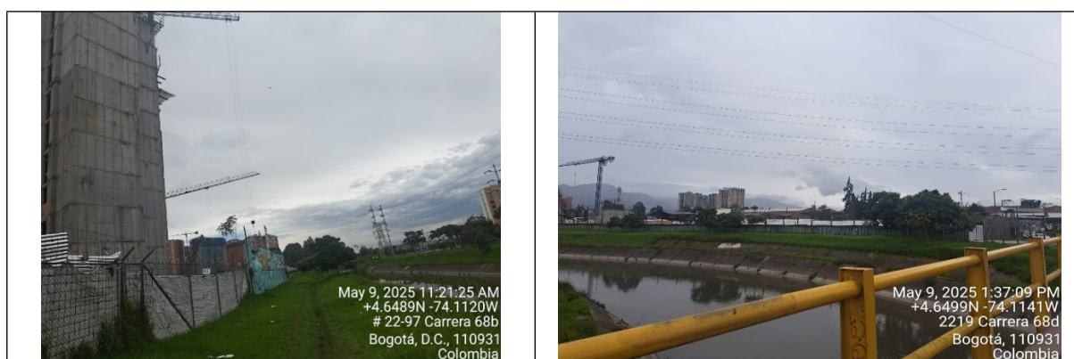
Fotografía No. 1 y 2. Cerramiento perimetral del frente de obra hacia estructura ecológica principal Canal San Francisco en óptimo estado.
