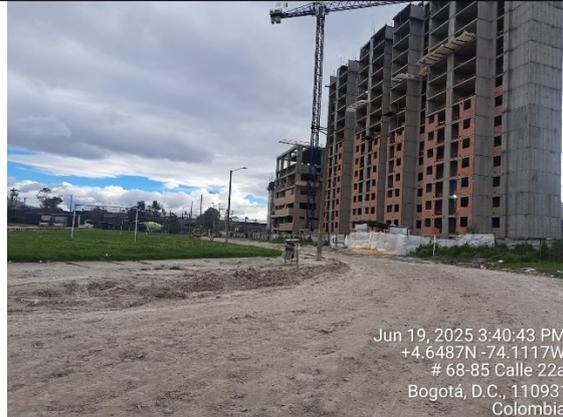
**Fotografía No. 13 y 14.** Presencia de material de arrastre sobre la carrera 68B.
