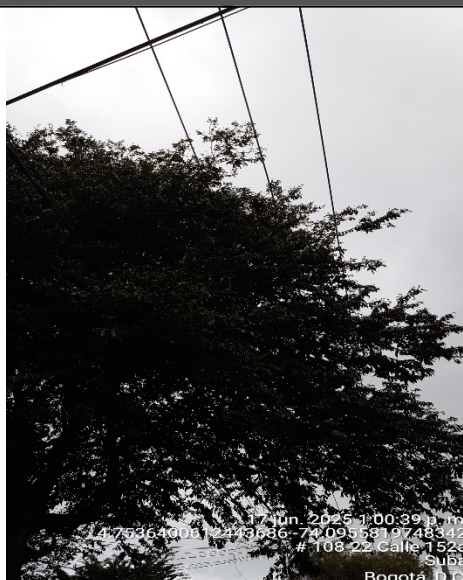
Foto 3. Vista de copa en contacto con rades de media tensión
