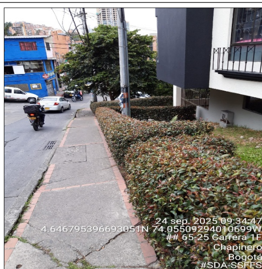
Foto No. 2. Foto de lo encontrado en campo.
