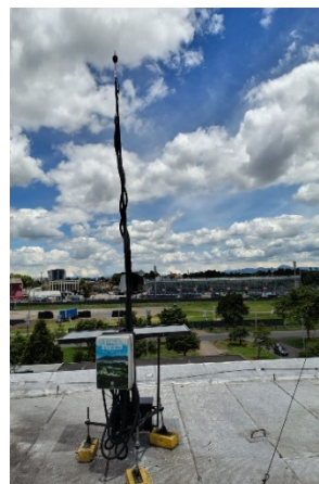
Fotografía 20. Estación de la red de ruido instalada en la terraza del Hospital Universitario Nacional
