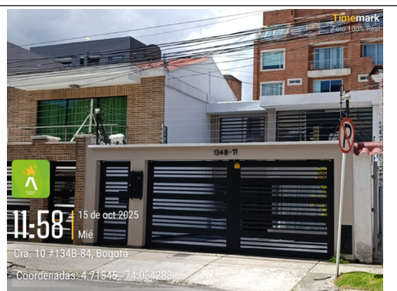
Fotografía 2. Vista general del predio.
