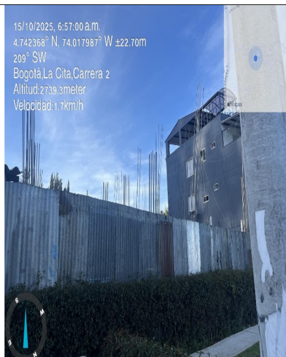
Fotografía No. 2. Exterior del predio ubicado en la carrera 2 # 166 A -20.
