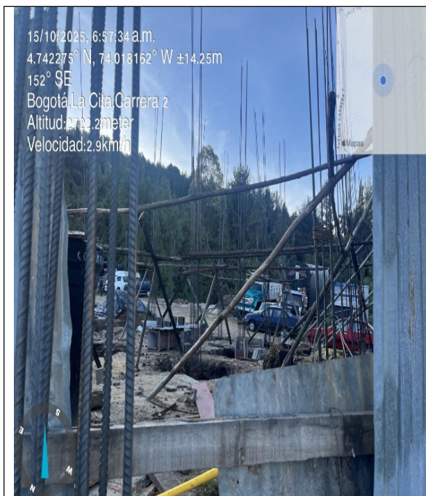
Fotografía No. 1. Interior del predio ubicado en la carrera 2 # 166 A -20, presuntas actividades constructivas.
