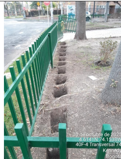
Foto 8. Vista detalle de deterioro de zona verde y endurecimiento.
