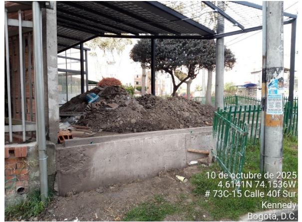
Foto 2. Vista general #1 estado actual de zona verde endurecida, en el costado nor-occidental de la dirección.
