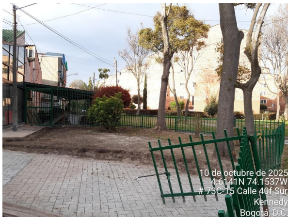
Foto 7. Vista general de deterioro de zona verde y endurecimiento.
