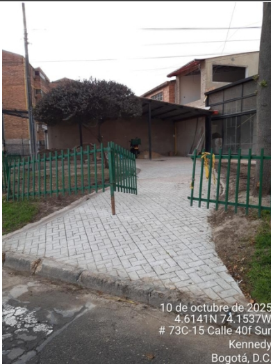
Foto 5. Vista general #3 estado actual de zona verde endurecida, en el costado nor-occidental de la dirección.
