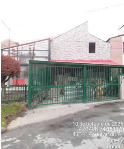
Foto 11. Vista general estado actual de zona verde endurecida, en el costado occidental (frente a la fachada) de la dirección.
