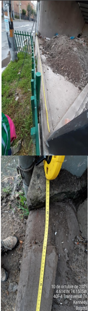
Foto 3. Vista general y detalle de medición realizada en sitio.
