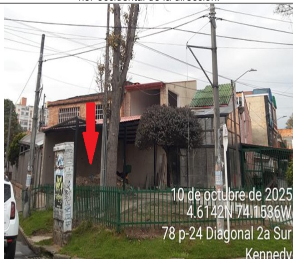
Foto 10. Vista general lugar donde se emplazaba árbol de Sauco al cual se aplicó intervención antitécnica.
