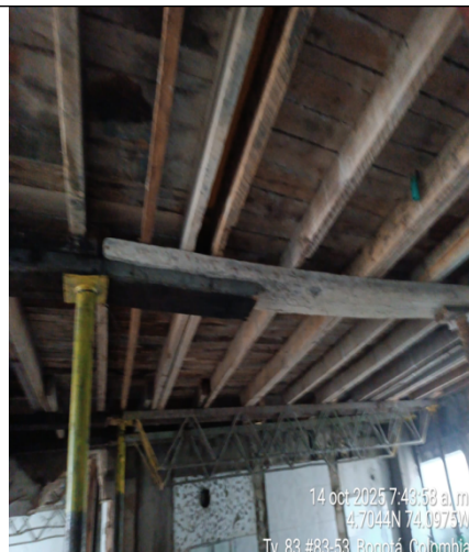
Imagen 4. Construcción de placa en concreto sobre el segundo piso de la vivienda.
