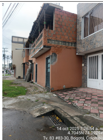
Imagen 5. Componentes del sistema de drenaje urbano sin cerramiento de protección
