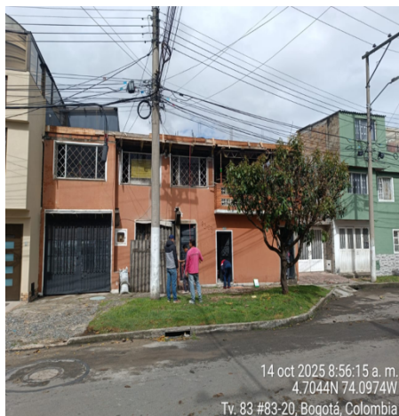
Imagen 1. Fachada principal de la vivienda, se evidencian sumideros sin mallas de protección.
