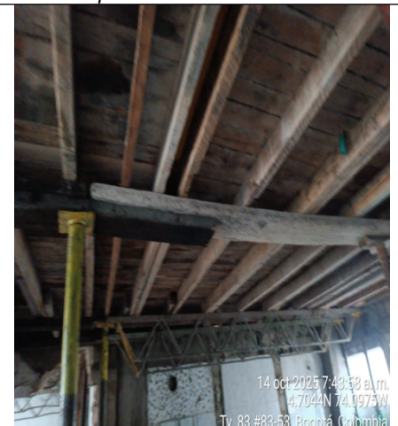
Imagen 4. Construcción de placa en concreto sobre el segundo piso de la vivienda.
