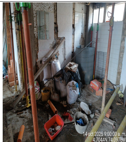
Imagen 6. Soportes y estructuras para fundir la placa en concreto sobre el segundo piso.
