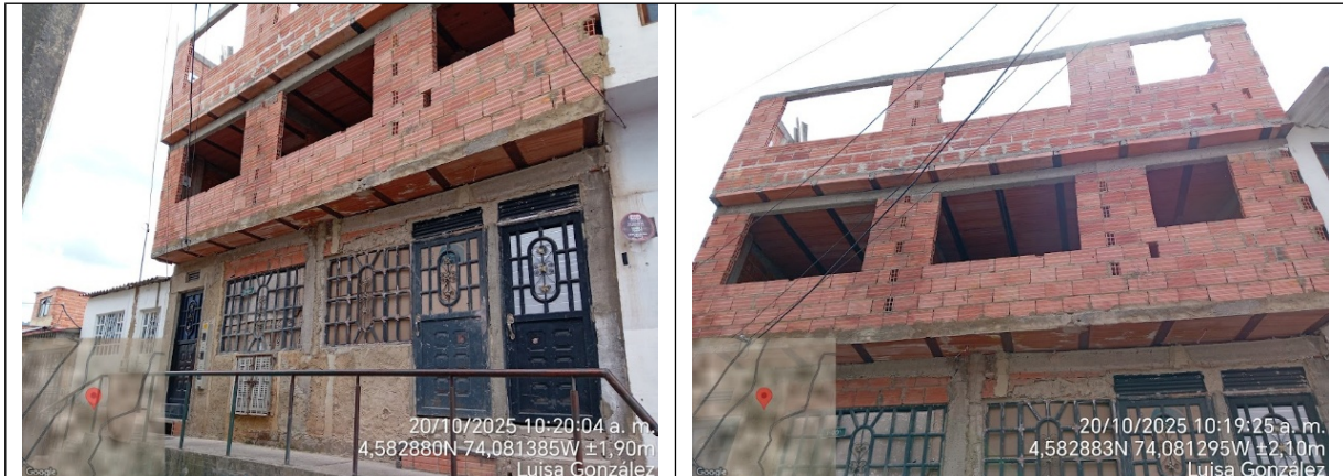
Fotografías No. 1 y 2. Predio con presuntas actividades constructivas ubicado en la carrera 5 No. 3-40 Sur.
