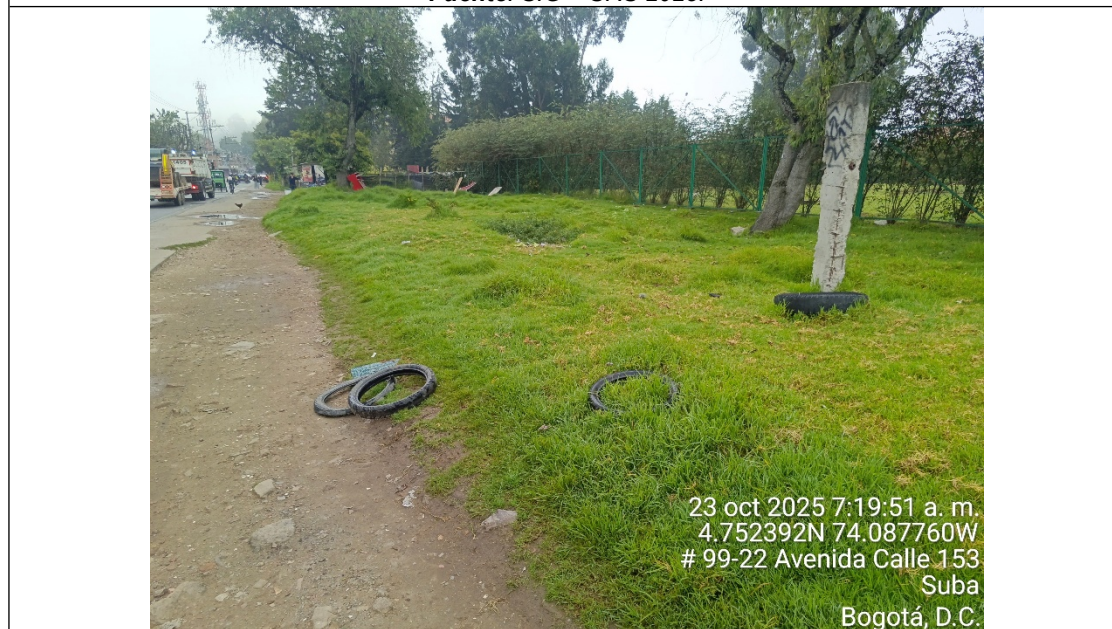
Fotografía 6. Se observan residuos RCD y llantas en el punto.
