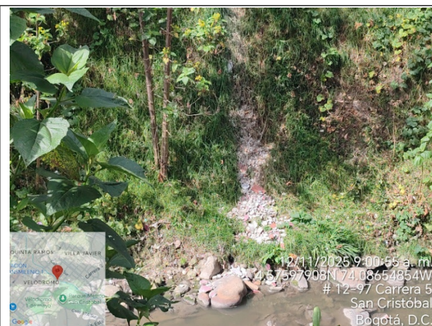
Fotografía No. 1- Costado sur del Río Fucha
