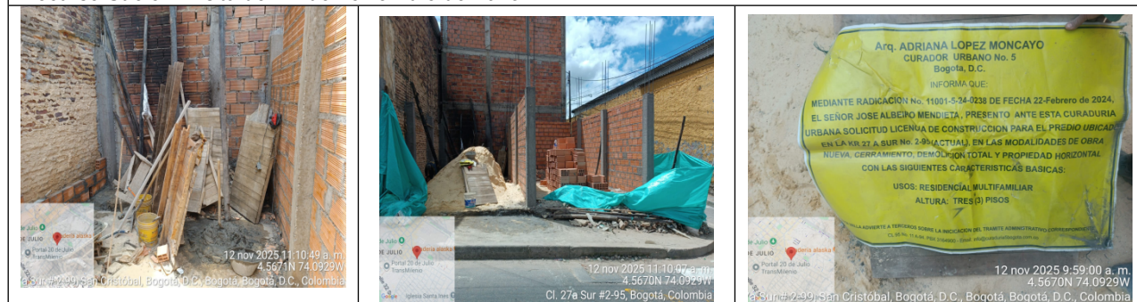
Fotografías No. 4, 5 y 6. Vista general externa del predio – materiales de RCD. Fuente. Subdirección del Recurso Suelo – Visita del 12 de noviembre de 2025.
