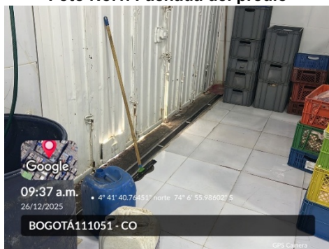
Foto No.3. Rejillas perimetrales
