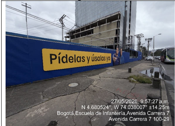
Vista panorámica del predio denunciado en la AK 7 NO. 101 – 27 de la localidad de Usaquén
