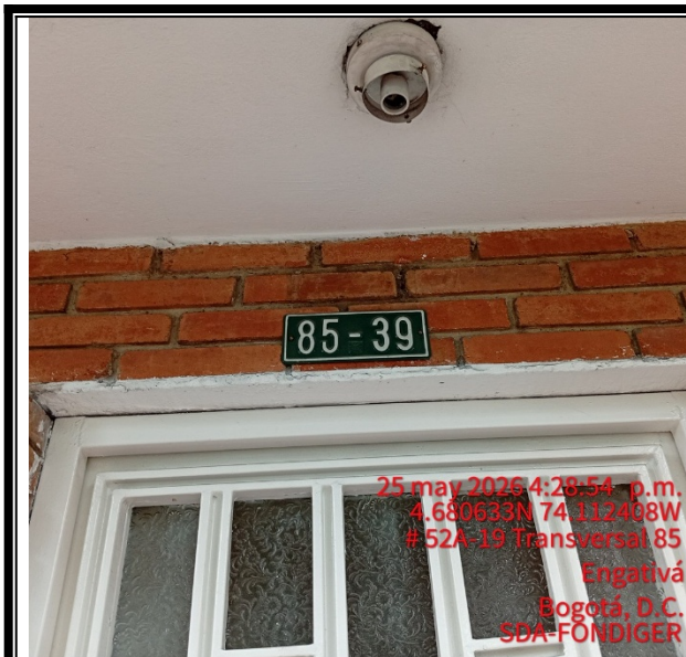
Foto 1: Detalle de nomenclatura de localización de la petición.
