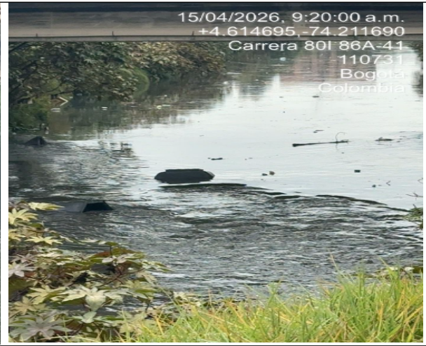
Fotografía 6. Se evidencian residuos en cauce permanente 4,614895, -74,2121690
